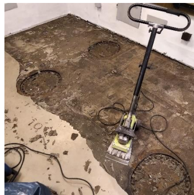
Mann- schafts- messe wird das alte Fußboden- belag entfernt
