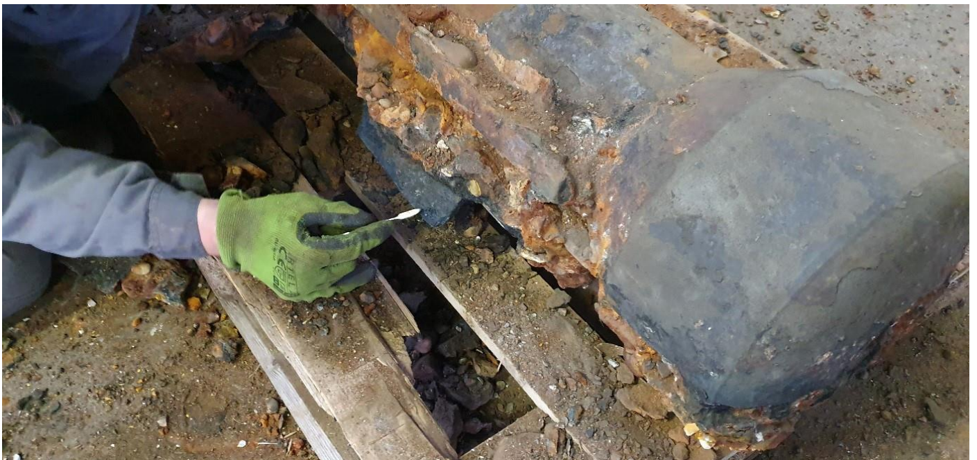
Manuelle Reinigung: mit einem Spatel werden schwarze Sedimentanhaftungen entfernt, 21.01.2020
