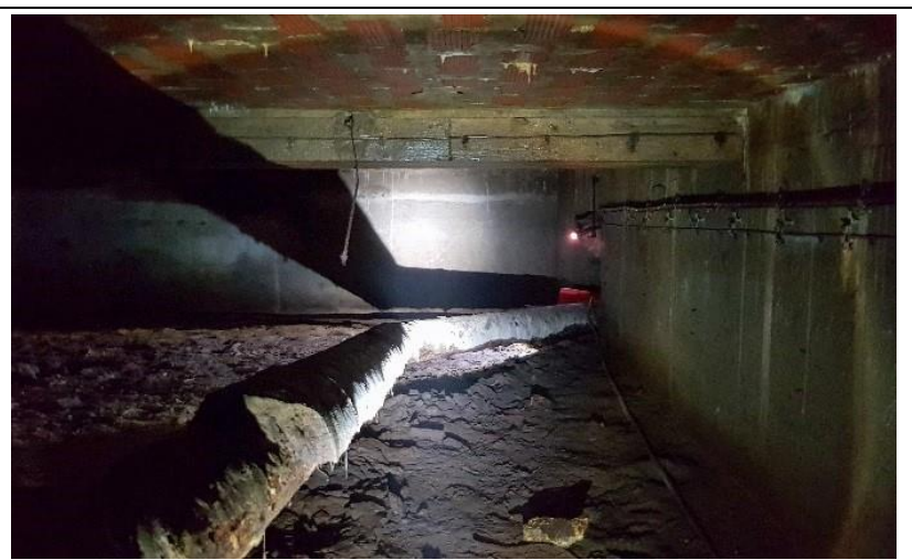
Kriechkeller zur Aufnahme von Rohren und Kabeln
