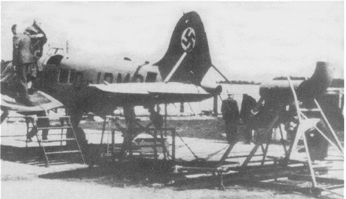
Die He 112 V-3 wird für einen Testlauf des im Heck montierten Walter Raketenmotors vorbereitet
