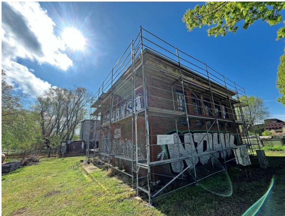
Das Wasserwerk in Peenemünde wurde im Jahr 1941 errichtet. Es sollte Kessel-Speisewasser und Trinkwasser für das Kraftwerk und das Hafengelände liefern. Foto: Henrik Nitzsche
