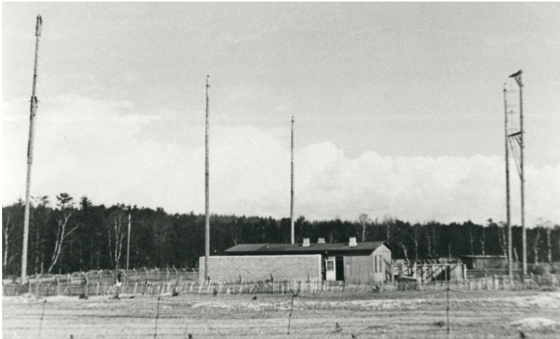
Adcock-Langwellen-Peilanlage Fu Peil A 50a bei Aakirkeby auf der Insel Bornholm
