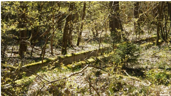
Heizungsstrang von der Wagenhalle zum VKN-Lager, zuerst unterirdisch (li., H) und dann auf flachen Betonstützen (I).
