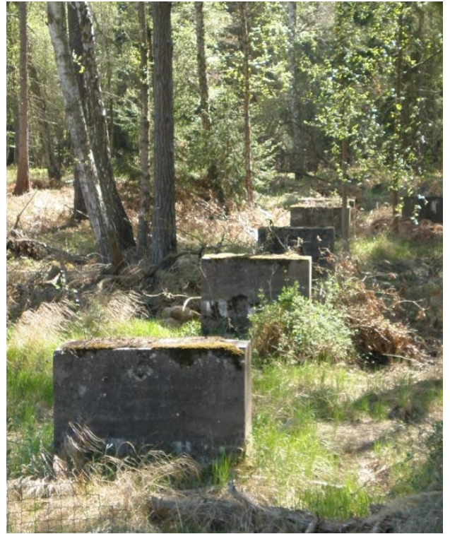
Die Stützen des nördlichen Stranges (C) entlang der Bahnlinie und dann durch den Wald ebenfalls bis zum Verteilergebäude.
