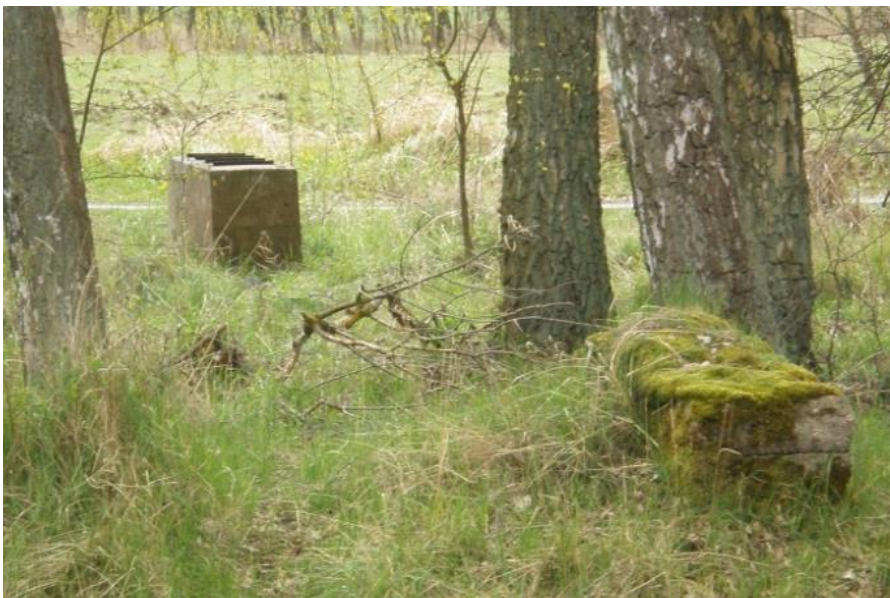
Zwei Betonstützen für die parallel laufenden Leitungen am Bahndamm (B) und dann für den südlichen Strang (D) durch den Wald bis zum Verteilergebäude
