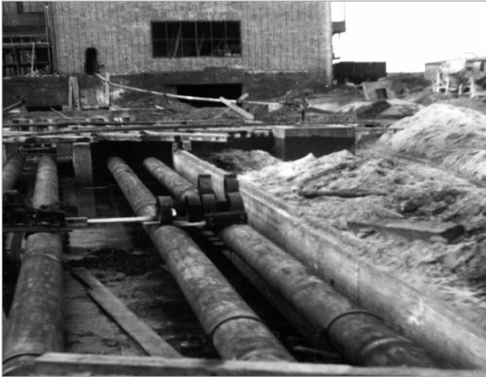
Die Fernheizungsleitungen auf dem Kraftwerksge- lände (A)
