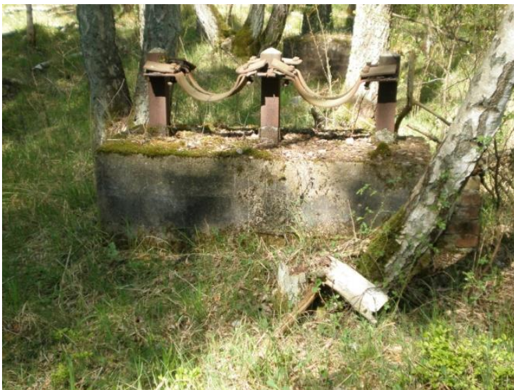
Die Stützen des nördlichen Stranges (C) entlang der Bahnlinie und dann durch den Wald ebenfalls bis zum Verteilergebäude.
