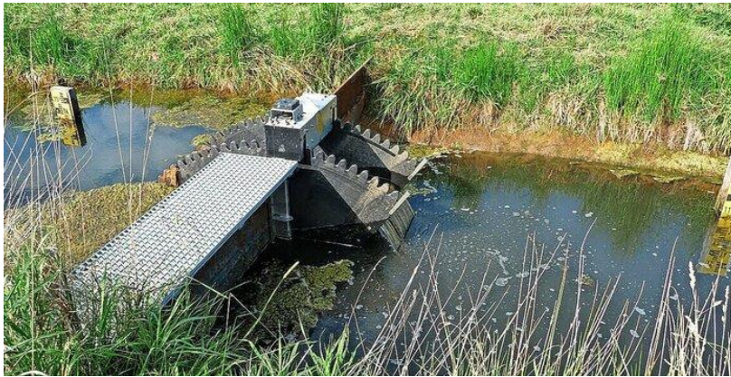
Regulierbare Stauwerke können den Grundwasserstand zentimetergenau steuern. foto: DBU
