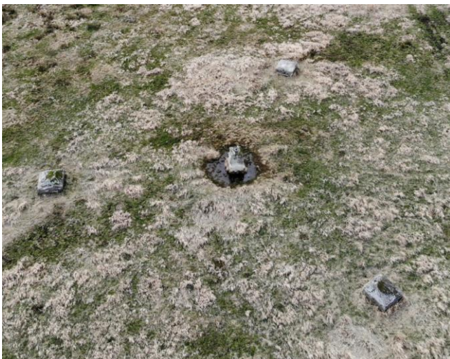
Die Fundamente für eine Antenne und die drei Abspannungen (Foto: Erik Teschendorff)
