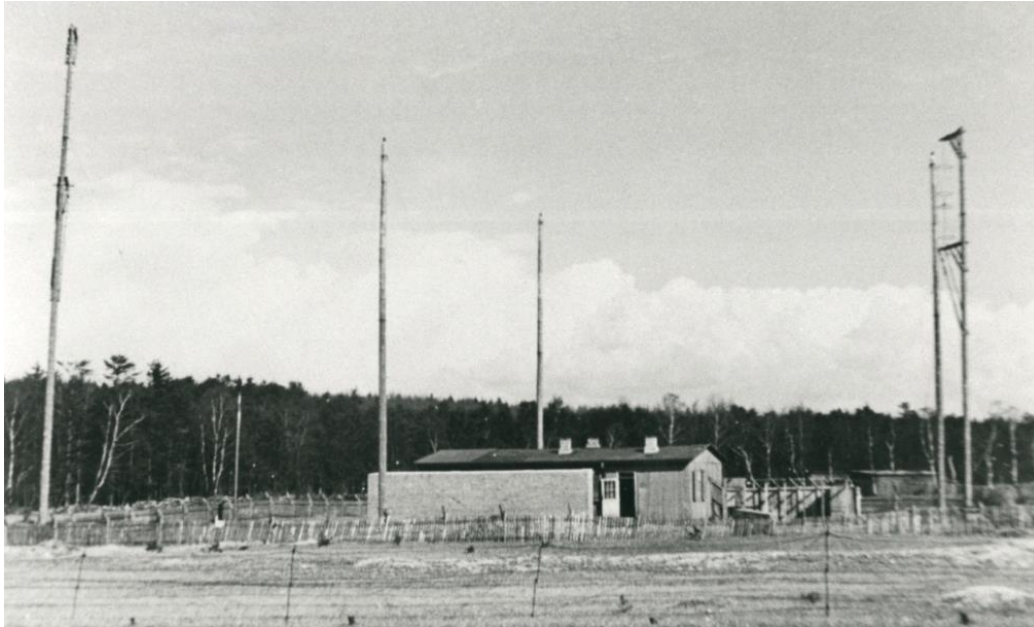
Adcock-Langwellen-Peilanlage Fu Peil A 50a bei Aakirkeby auf der Insel Bornholm (Foto: Bildstelle Peenemünde West, L 50-10)
